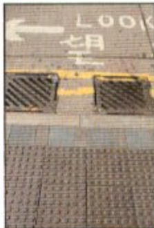
一排矩坑渠蓋貼在下斜路緣
